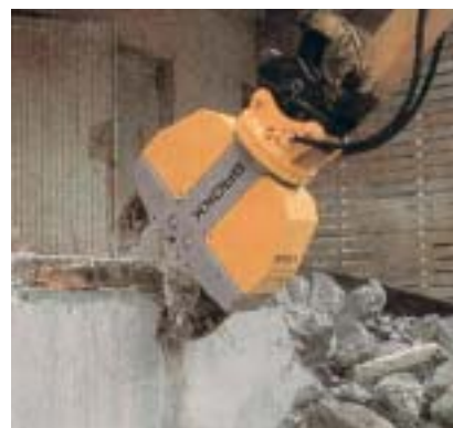
Démolition de construction par la cisaille à béton.
