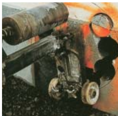
Démolition de construction par la cisaille à béton.
